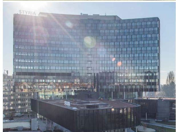
Styria Media Center - image source: Kleine Zeitung Gmbh CoKG, Jürgen Fuchs
